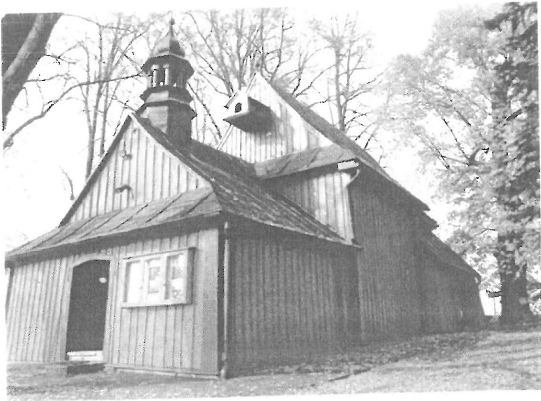
Fot. 2 Tęgoborze. Kościół p.w. Narodzenia NMP na górze św. Justa -- widok od strony południowo-zachodniej
