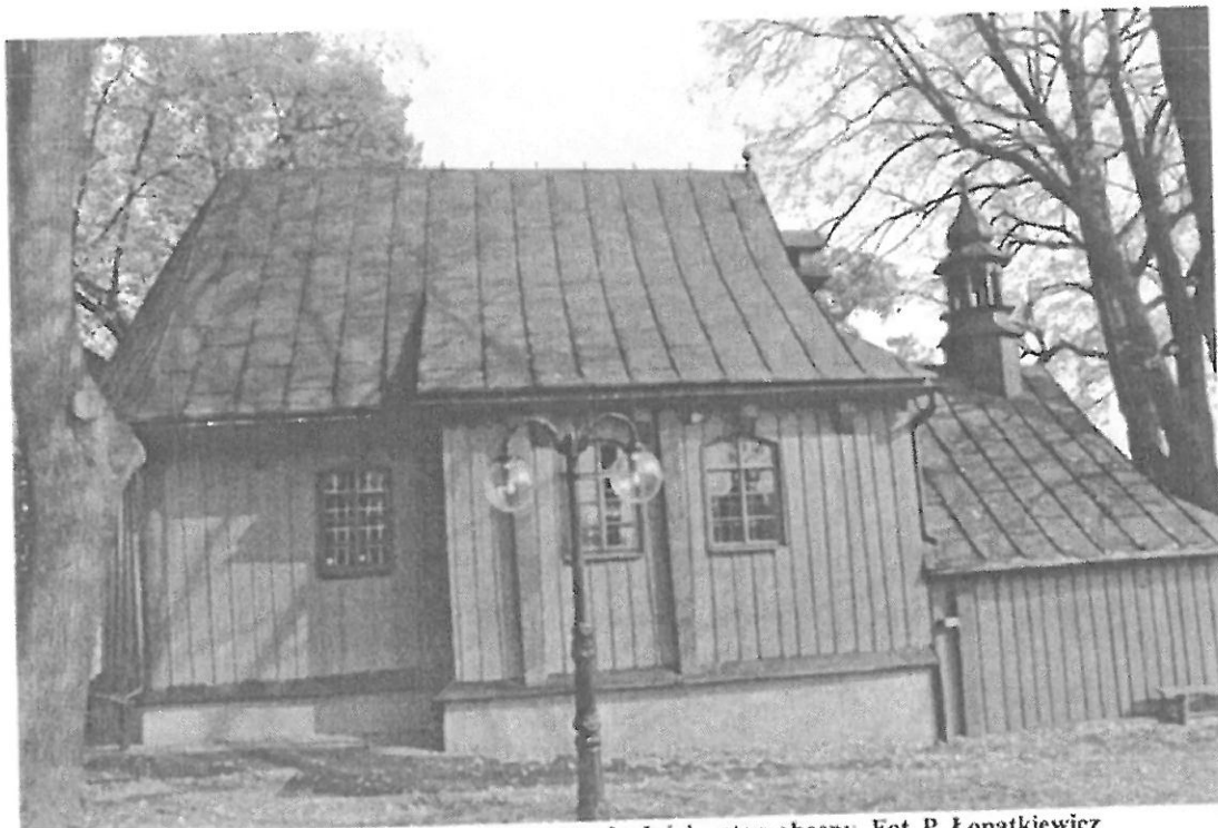
2. Kościół w Tegoborzu-Juście – widok od strony zachodniej – stan obecny. Fot. P. Łopatkiewicz
